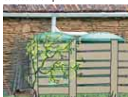
bacs à récupération d'eau
