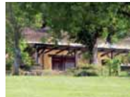
structure en bois
