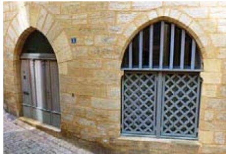
Maçonnerie calcaire ocre
