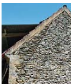
Pignon rehaussé en lauzes
