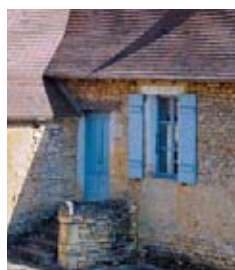
Toit en tuiles plates
