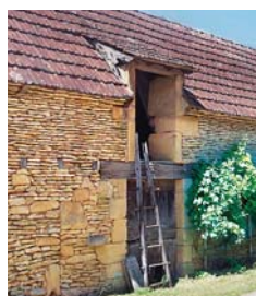
Mur rehaussé en lauzes
