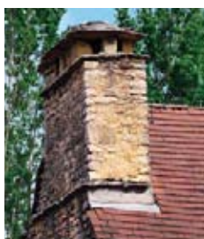
Cheminée trace de lauzes
