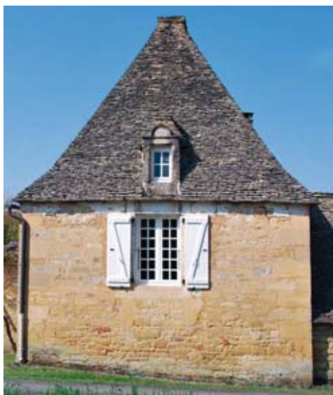
Toit en lauzes, murs enduits et bandes chaulées
