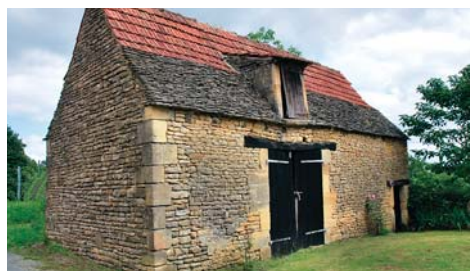
Grange étable à rez-de-chaussée
