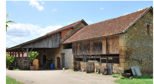
alignement de grange étable et de abri à cochons-séchoir
