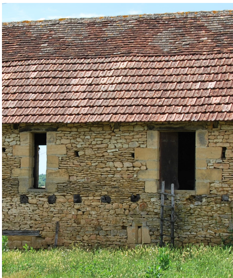
mur en moellons de calcaire et lauze de récupération
