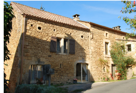
Rénovation en cœur de hameau
